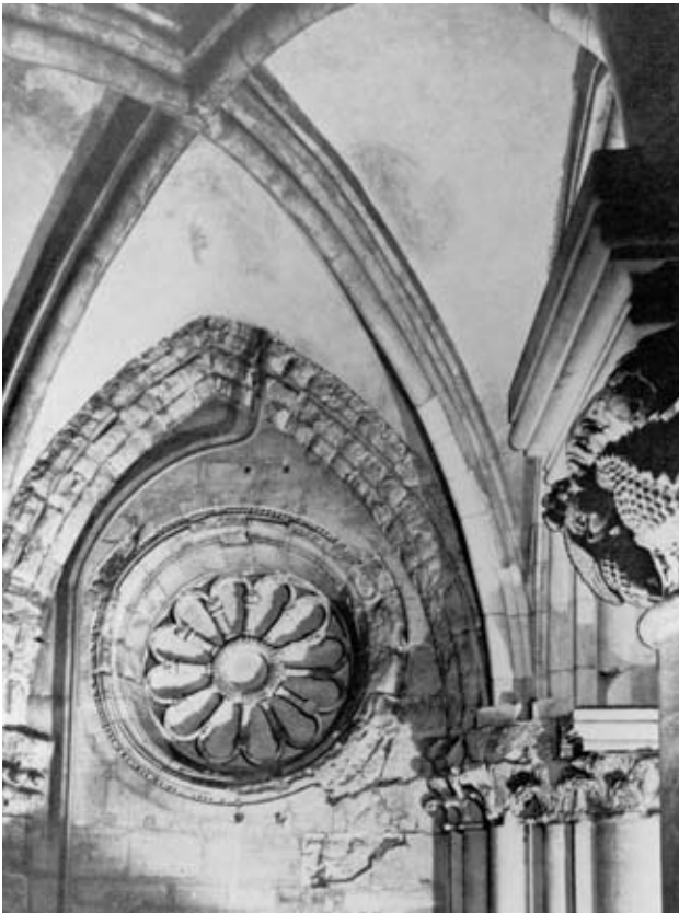
Abb. 13: Westempore, Blick in den nördlichen Heidenturm mit dem nach 1945 freigelegten romanischen Radfenster
