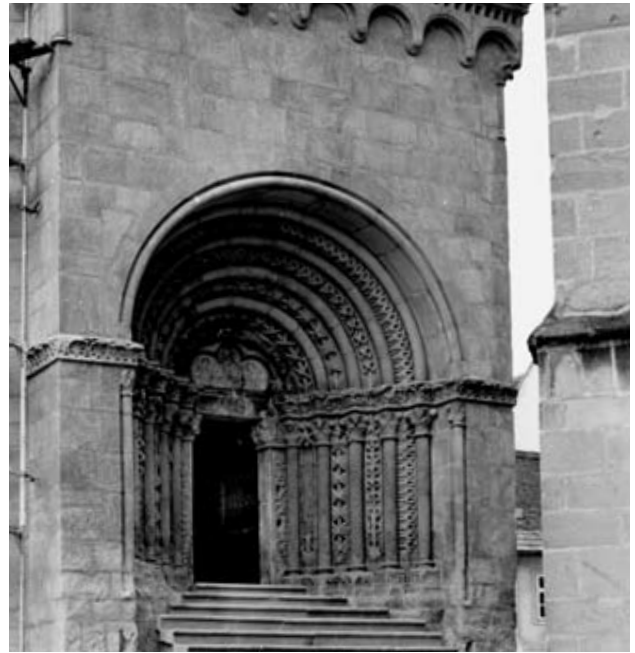
Abb. 7: Tulln, Ansicht des Karners mit Portalvorbau, 2. Viertel des 13. Jahrhunderts
