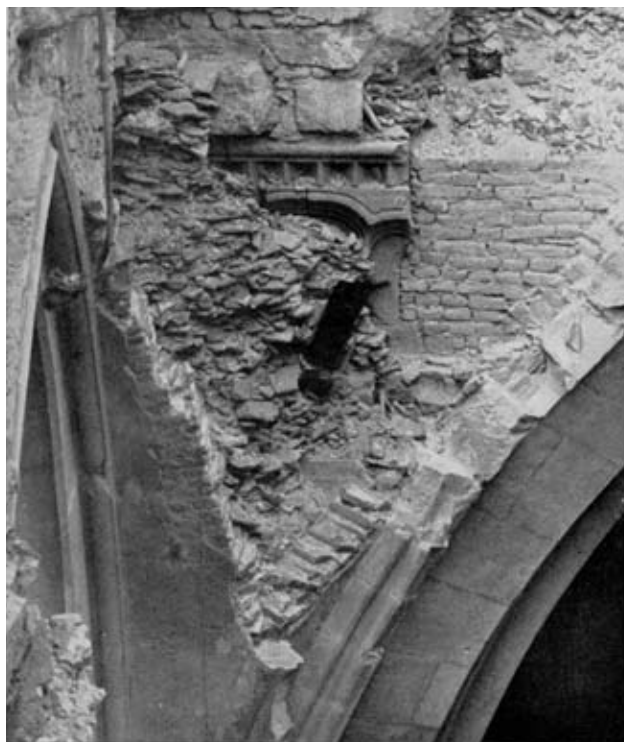
Abb. 12: Blendarkadenfries an der Ostwand des südlichen Querschiffflügels (über dem 1945 eingestürzten Chorgewölbe), Photo aus dem Jahr 1945
