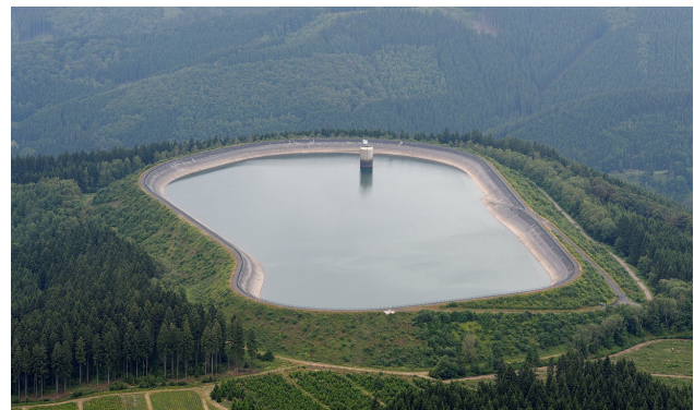
Pumpspeicherkraftwerke sind heute die am weitesten verbreitete und bewährte Stromspeichertechnologie.
