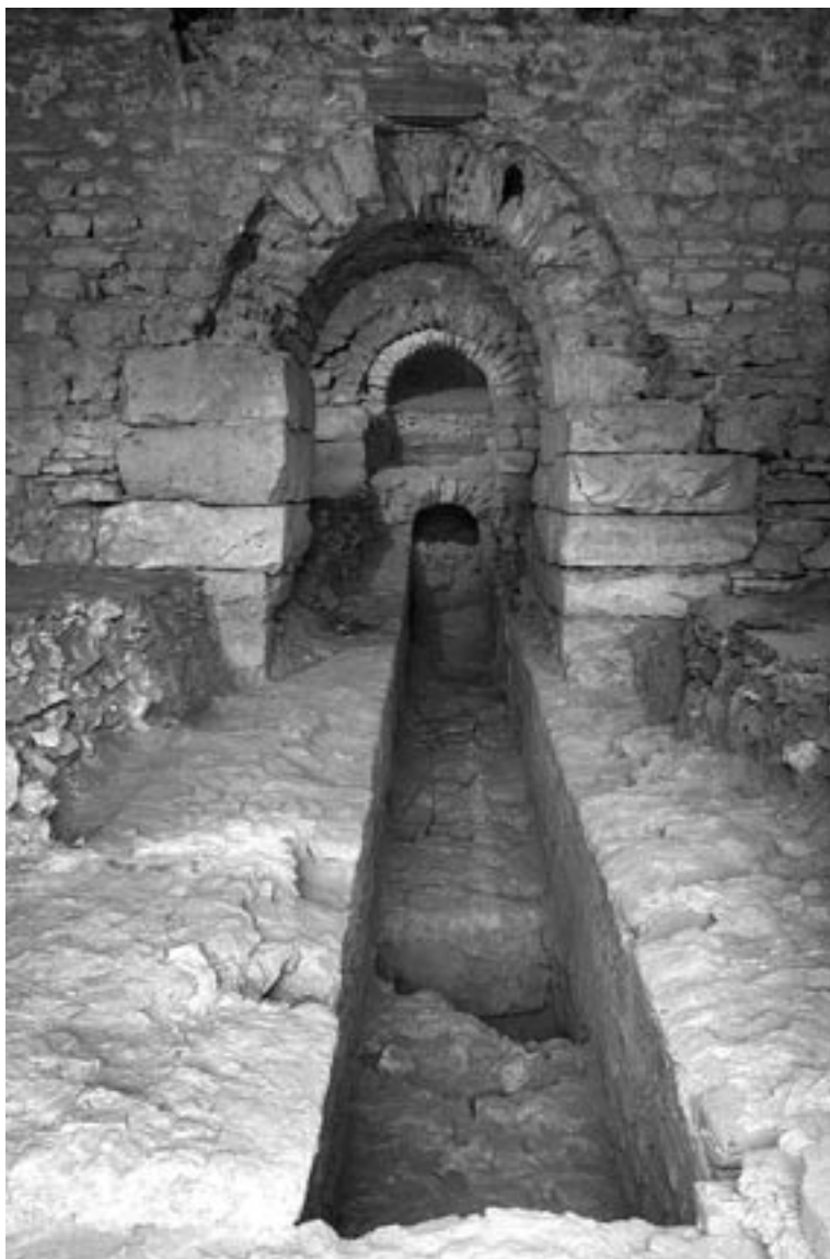
3 Schnitt 3/02 mit freigelegtem Abwasserkanal. Raum H und M
