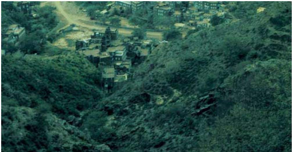
Abb. 65: Madīnat Rijāl Alma ç : Siedlungsanlage am Talschluß
