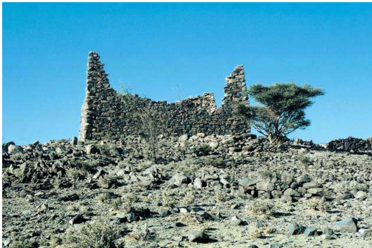
Abb. 57: Verfallenes Steinhaus auf Hügelkuppe bei al-'Aqīq
