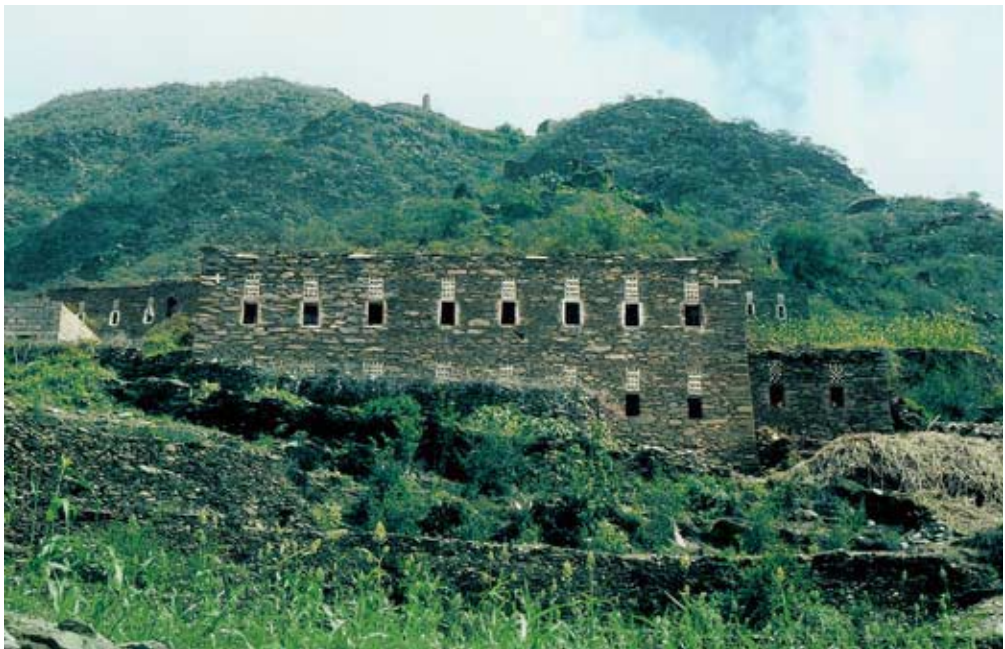
Abb. 61: Zwischenschacht-Gebäude (ohne rückversetzte Fassadenstreifen) am J. Šalab, Rijāl Alma 6
