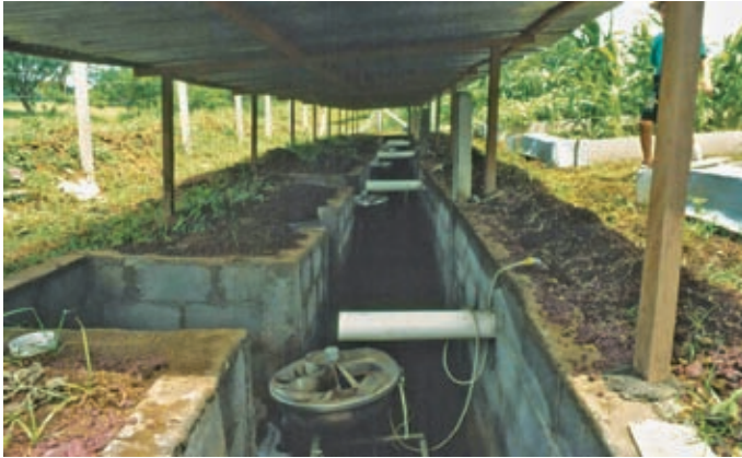
Foto 10: Aufbau der Messvorrichtungen für die Erosionsmessparzellen. Im Vordergrund sichtbar sind Teile der Sammelvorrichtung mit Zulaufrohr aus den Messparzellen und Coshocron Rad zur Probenteilung. Rechts sichtbar sind Teile der Messparzellen mit Mais und Bohnen (© Axel Mentler).
