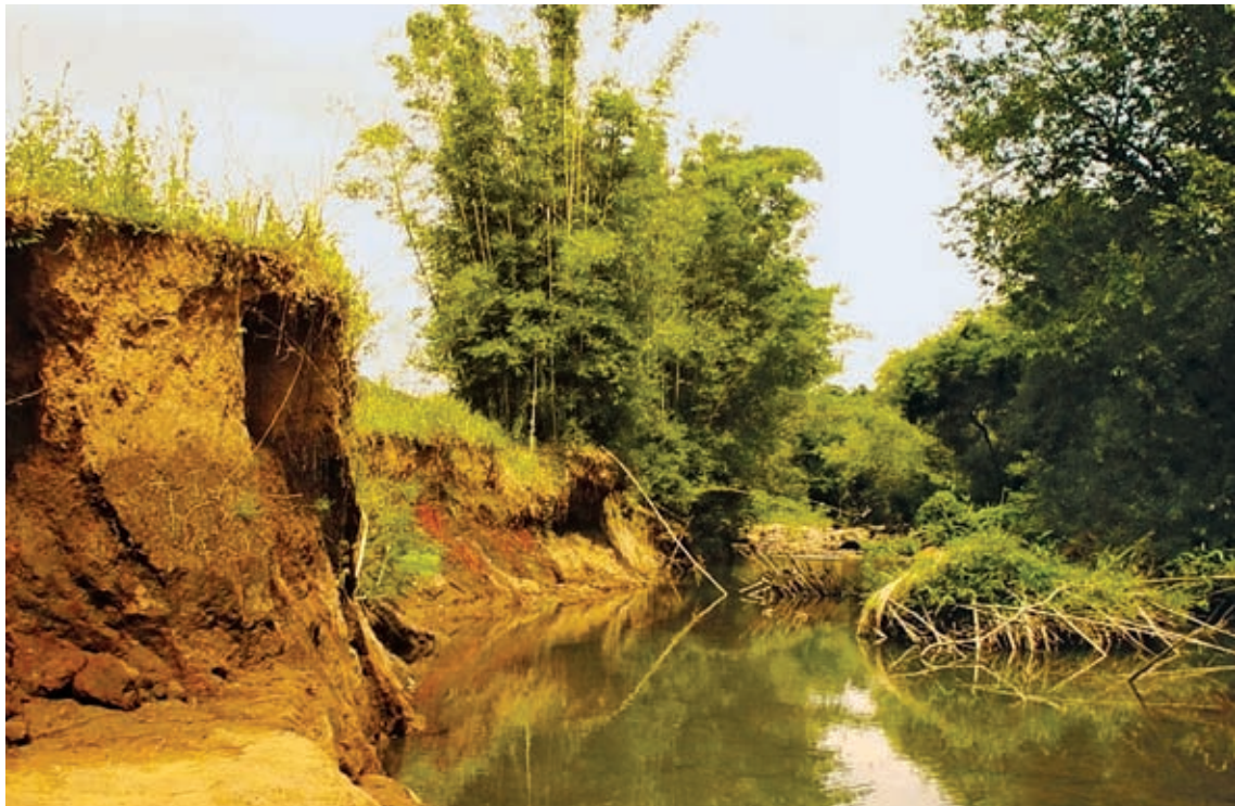
Foto 33: Erodierter Flussufer des Arroio Guarda-mor (2003) (© Fabrício J. Sutili).
