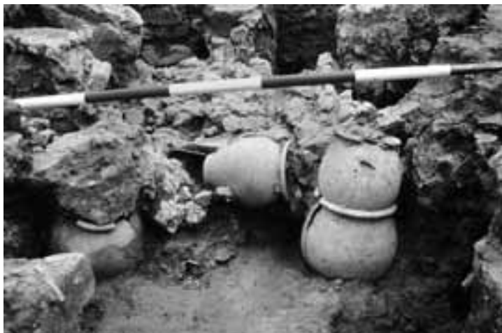
Abb. 49: Töpfe in Sekundärverwendung als Verlängerung radialer Stützpfiler in der Heizkammer des Keramikbrennofens O53.
