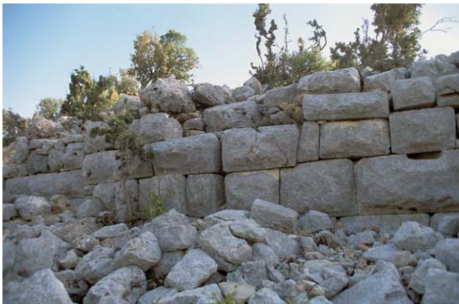
Abb. 26: Orokenda/Gölcük Ören, Mauer aus Bossenquadern mit Randschlag
