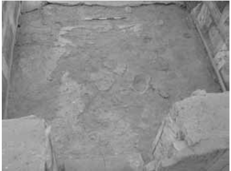
14 Unterkonstruktion des Mosaikbodens in Raum 25 (Sondage 3)
