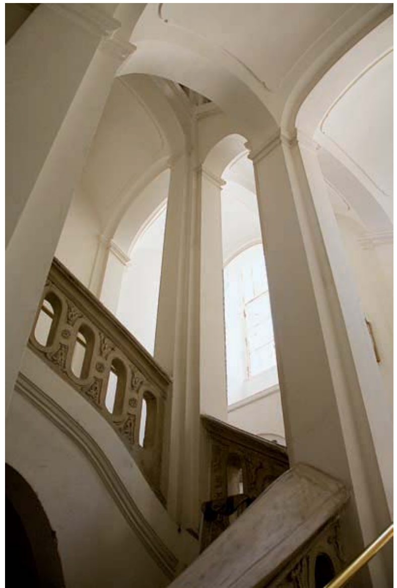
AKADEMIE- GEBÄUDE, NORDSEITIGER STIEGENAUF- GANG (ABB. 31)
