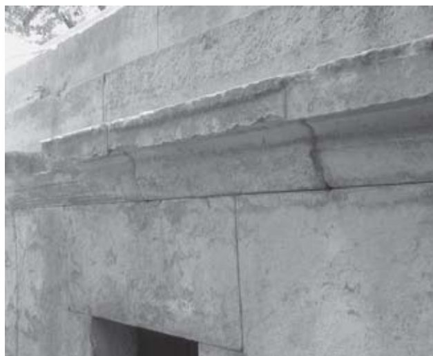
Abb. 15: Oktogon, nicht fertig ausgearbeitete Südseite
