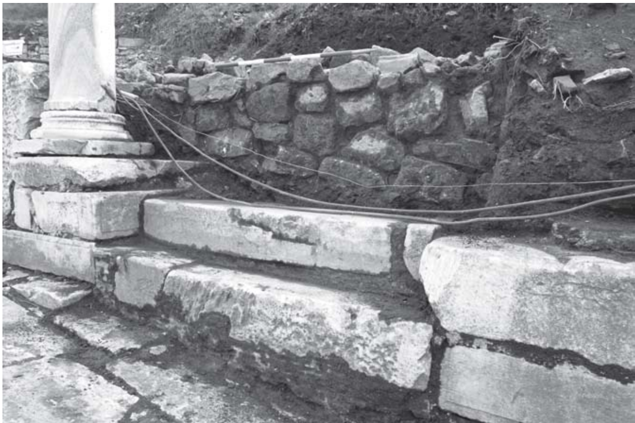
Abb. 6: Kuretenstraße, Südhalle: Detail SEM 3 und Stufen (nach Süden)
