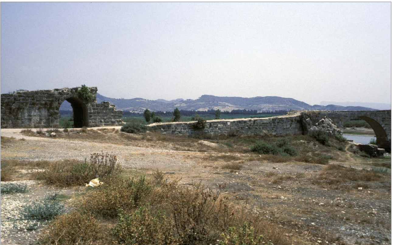
Abb. 14: Römische (bereits verfallene) und seldschukische Brücke über den Eurymedōn zwischen Attaleia und Sidē in Pamphylien.
