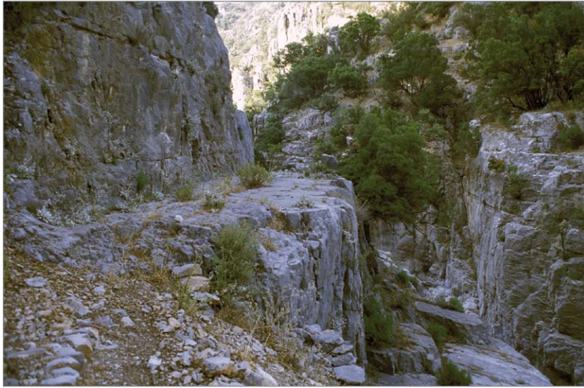
Abb. 10: Aus den Felsen gesprengte römisch-byzantinische Straße in den Stena westlich von Attaleia.
