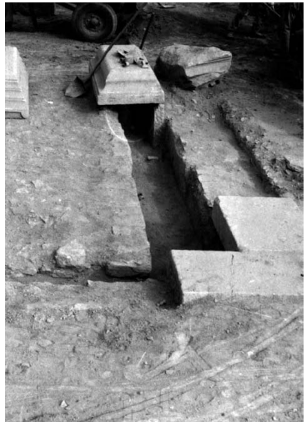
3 Freilegung der Südostecke des Stylobats des Vorhofes
