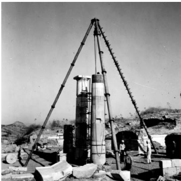
1 Prytaneion. Rekonstruktion der dorischen Ordnung der Vorhalle (1964)
