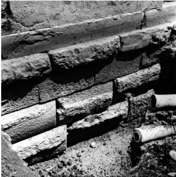
2 Prytaneion. Sondage VIII (1961). Nordwand der Vorhalle
