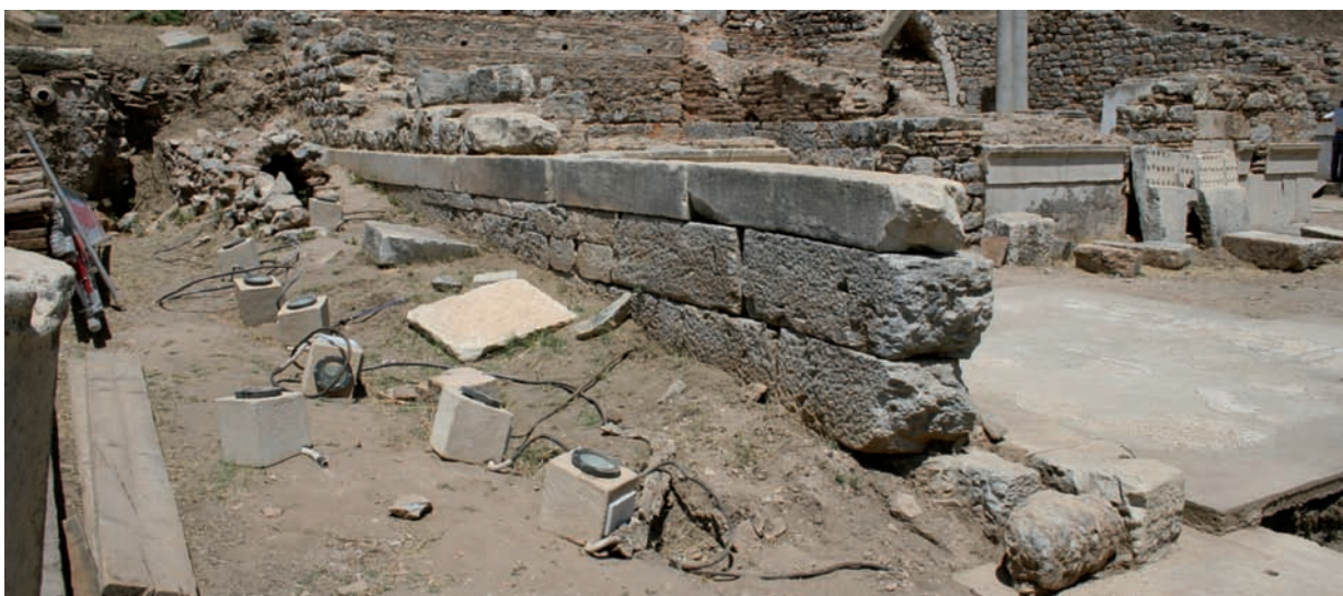
3 Vorhalle. Westliche Antenmauer von Westen
