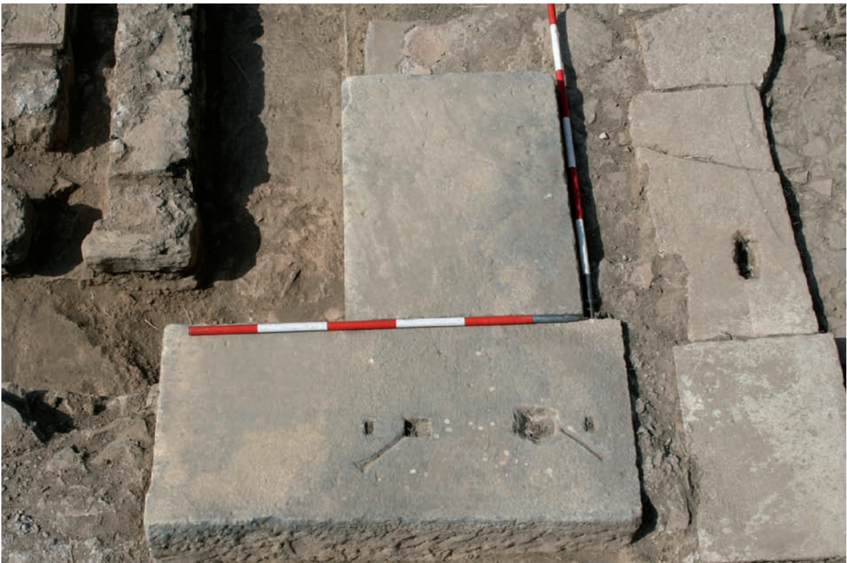
2 Stylobatblöcke der Südostecke
