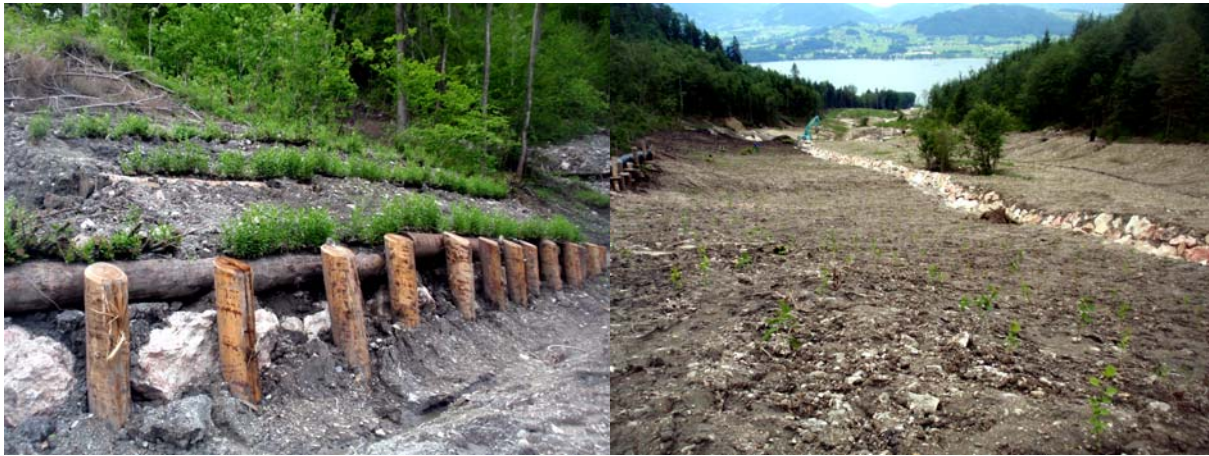
Abb. 21 und 22: Lärchenpilots und Weidenspreitlagen (links); Erosionssichere Neuanlage von Gerinnen und dichte Aufforstung mit Schwarzerlen sollen den Oberbodenabtrag minimieren (rechts).
