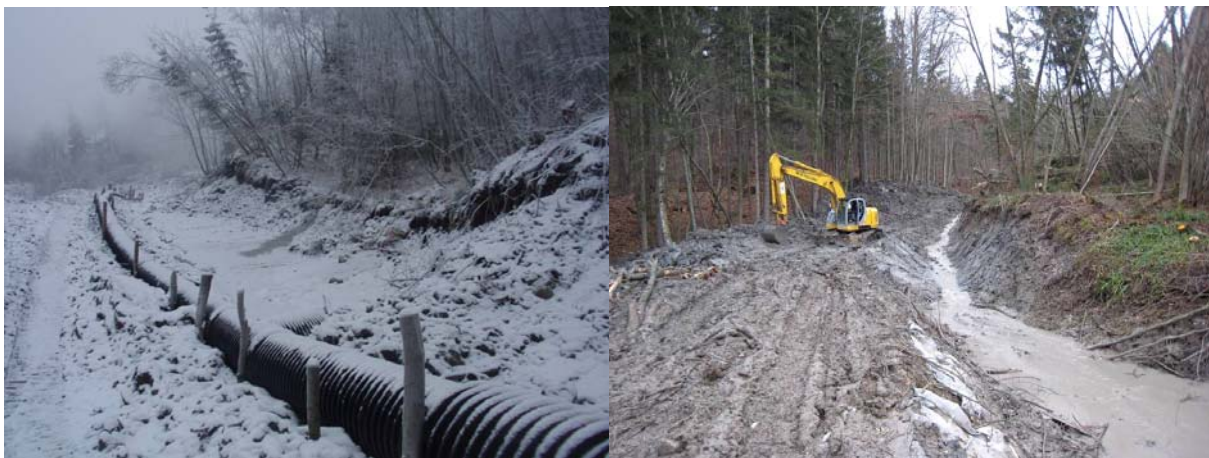
Abb. 7 und 8: Rohrausleitung (links) Baggereinsatz zur Wasserausleitung und Wegerrichtung
