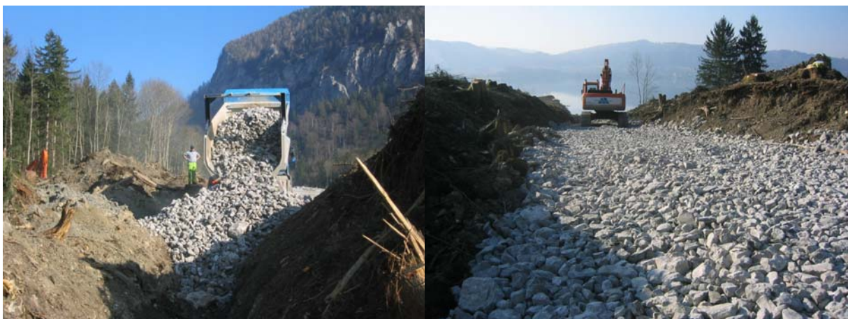
Abb. 11 und 12: Auffüllen der Drainagegräben mit Kalkgrobschlag 100/300 (links); Drainagegräben wurden so angelegt, dass sie gleichzeitig als Baustellenstraßen dienten (rechts).
