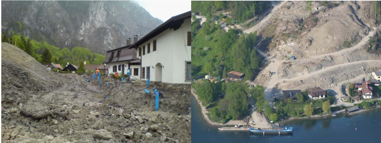
Abb. 17 und 18: Brunnenreihe unmittelbar bergwärts der betroffenen Häuser (links); Abtrag der Aufwallungstirn oberhalb der Gebäude und Materialabtransport mittels Klappschute.
