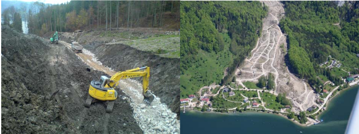
Abb. 13 und 14: Die untere der beiden Querausleitungen (links); Abb. 14: das Netz von Querausleitungen und Dränagegräben wirkt wie ein Stützrippengefüge
