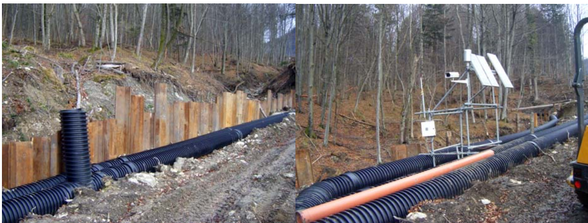
Abb. 15 und 16: Abspundung des Lidringgrabens gegen den Zentralbereich der Rutschung (links); um die Wirksamkeit der Ausleitungen überwachen zu können, wurden hydrologische Messstationen durch die Universität für Bodenkultur in Wien installiert.
