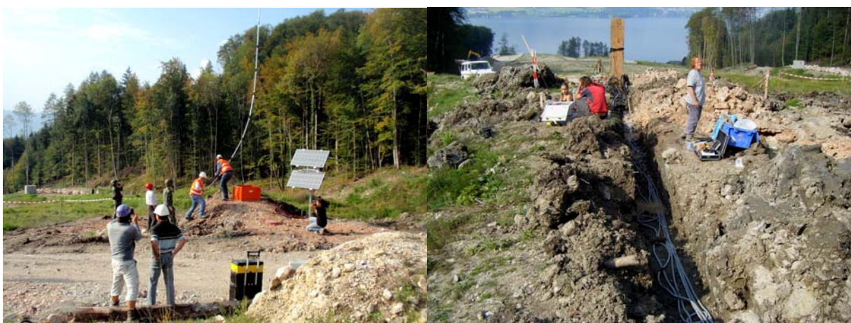
Abb. 23 und 24: Installation des Ketteninklinometers mittels Helikopter (links); Anlage der Geoelektrik-Messstrecke (rechts).
