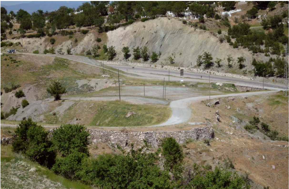
47 Substruktionen der römischen Straße auf den Burgberg von Tabai (Davas, Kale)
