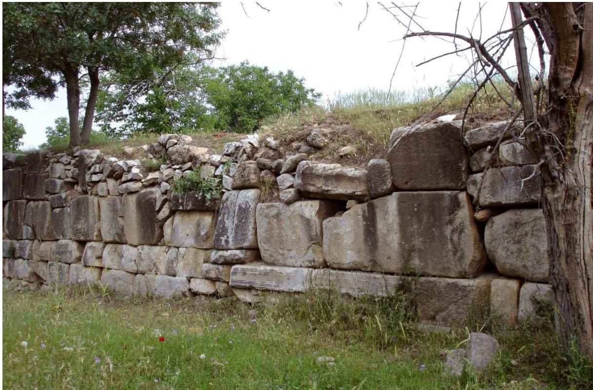
43 Frühbyzantinische Stadtmauer aus Spolien in Hērakleia Salbakēs
