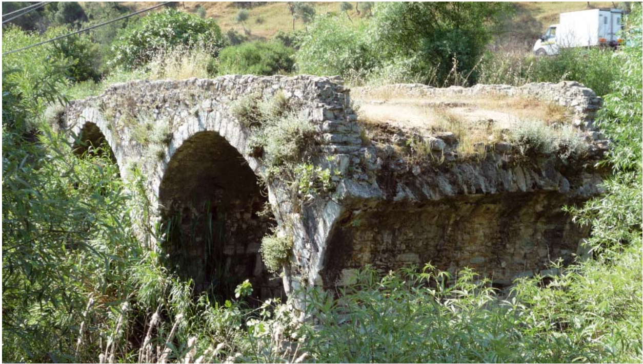
27 Brücke über den Sarı Çay (Keniös) 2008
