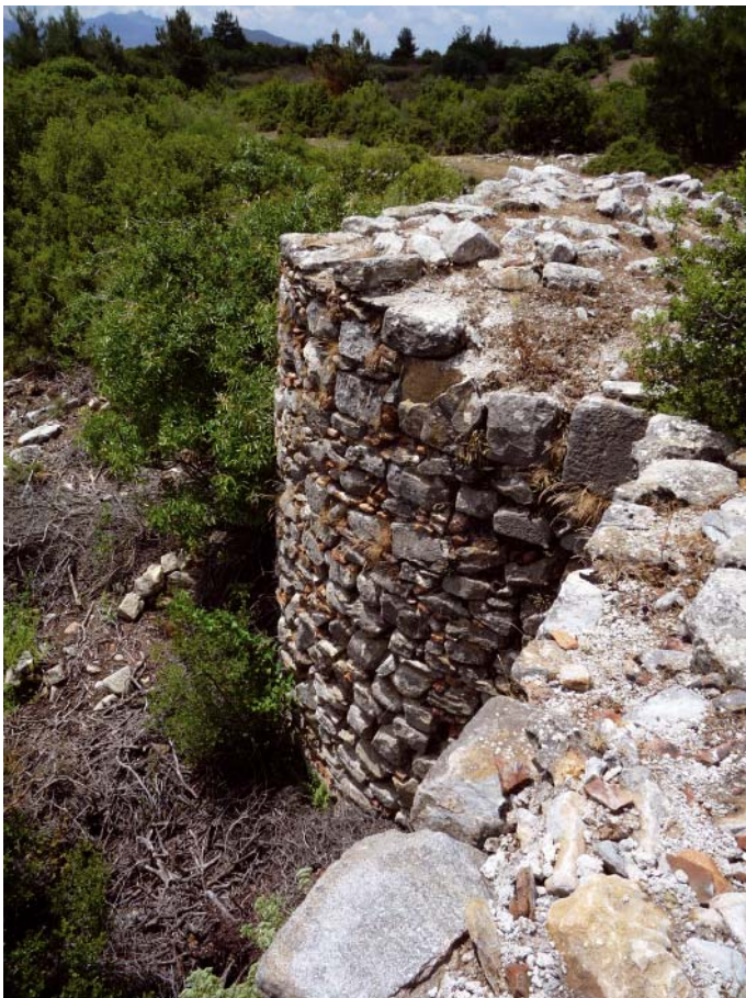
33 Byzantinischer Turm in der Stadtmauer von Amyzön
