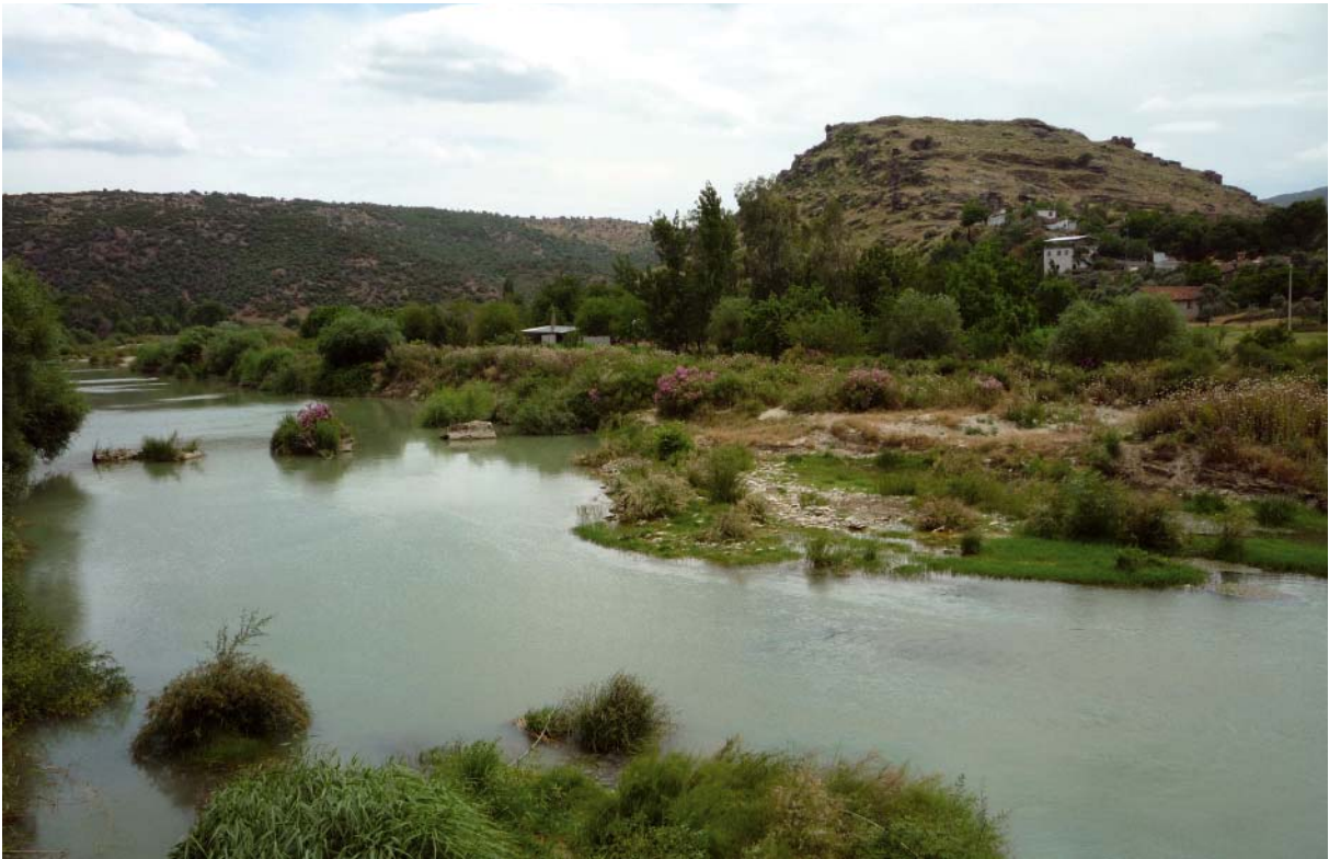
52 Pfeiler der Brücke über den Marsyas in Eskişehir mit Blick auf die Akropolis
