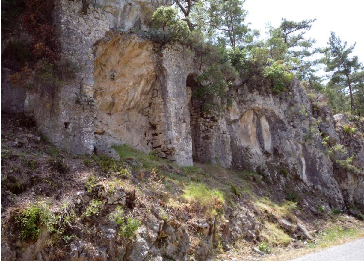
9 Aquäduktpfeiler an der „Küstenstraße“ von Keramos nach Osten
