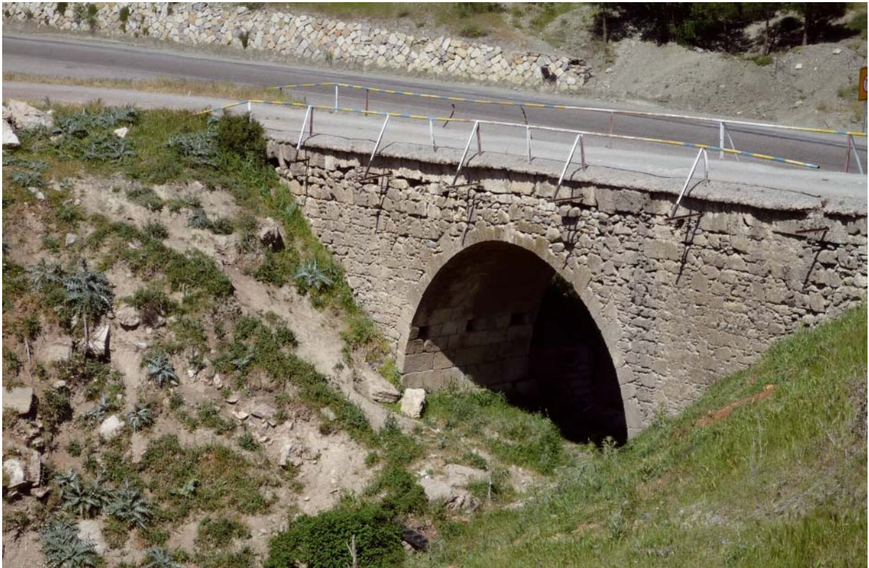
44 Alte Einbogenbrücke am Ostfuß des Burgberges von Tabai (Davas, Kale)
