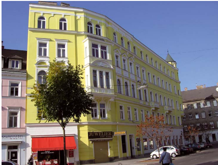
Foto 1: Fassade mit neuem Verputz, 1050 Wien
