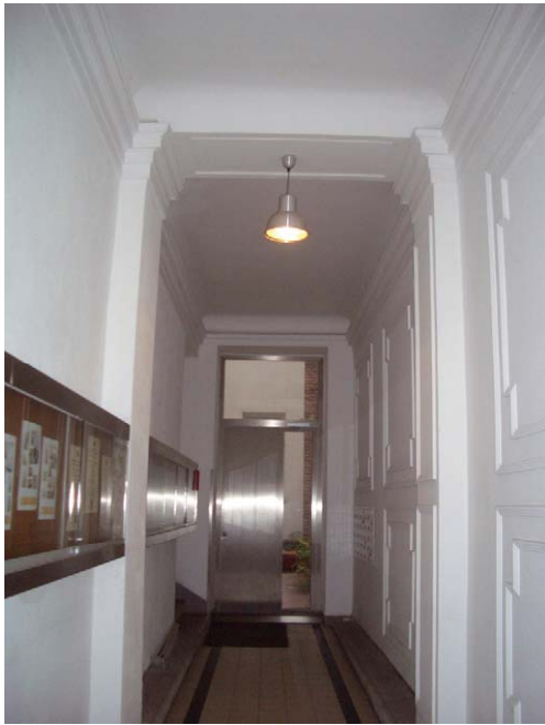
Foto 3: 1981 und 2005 neuer Verputz im Flur, 1140 Wien
