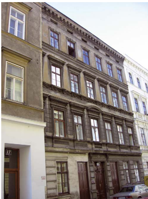
Foto 2: Haus mit altem Verputz, 1040 Wien
