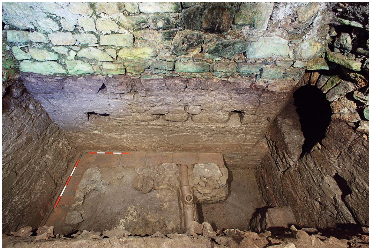
3 Sondage 5/2010: umlaufender Latrinenkanal mit Fundamentsondierung vor Durchgang zu Kammer 5b
