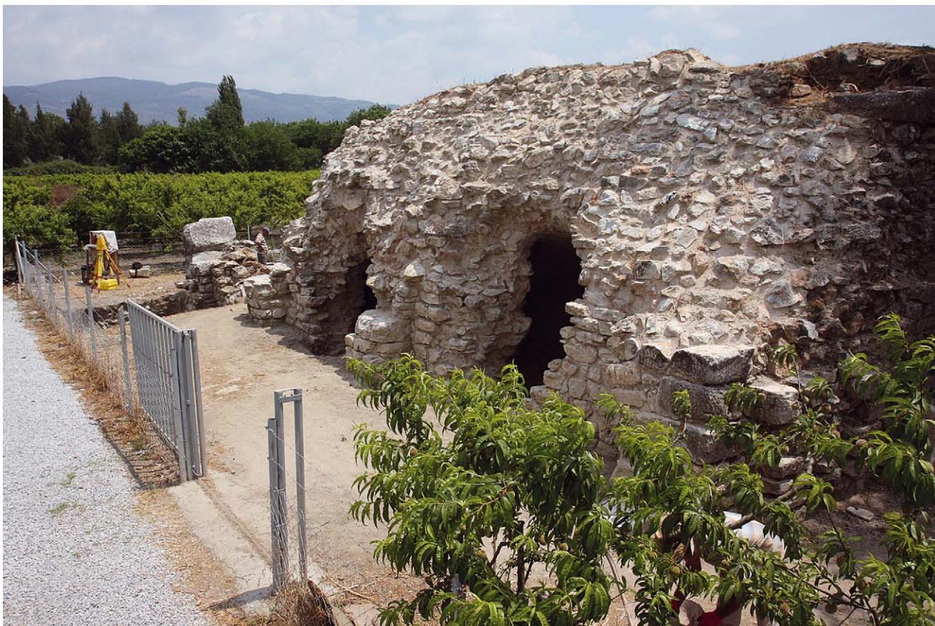
1 Nordfassade nach der Sicherung (2010)
