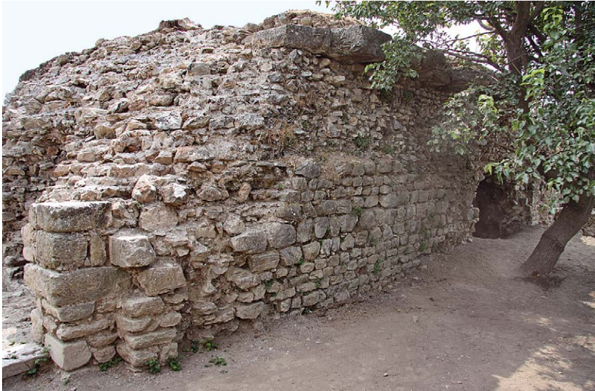
1 Westfassade: opus caementicium -Kern mit opus vittatum -Schale
