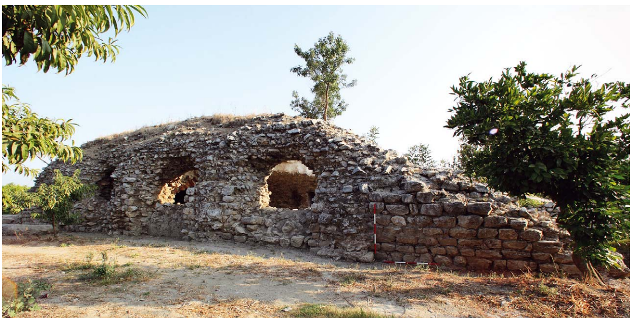
4 Südfassade: Blick nach Nordwesten
