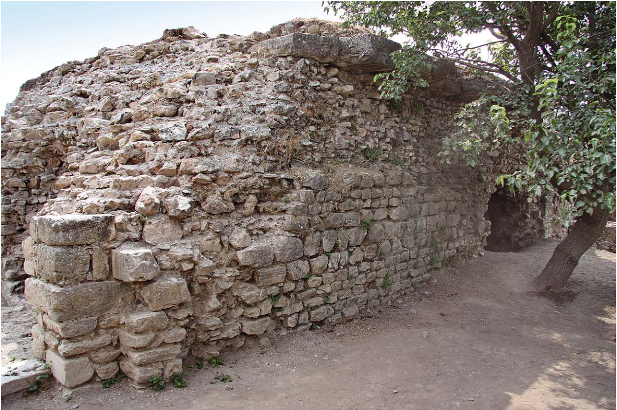
1 Nordwestecke mit Gurtgesims aus Kalksteinblöcken in situ
