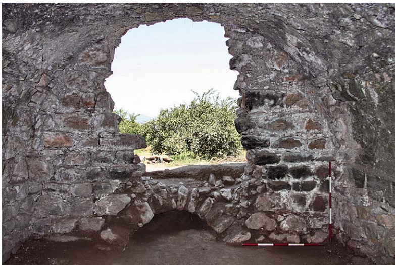
2 Kammer 6 mit dem bauzeitlichen Zugang, darüber mittelalterlicher Durchbruch
