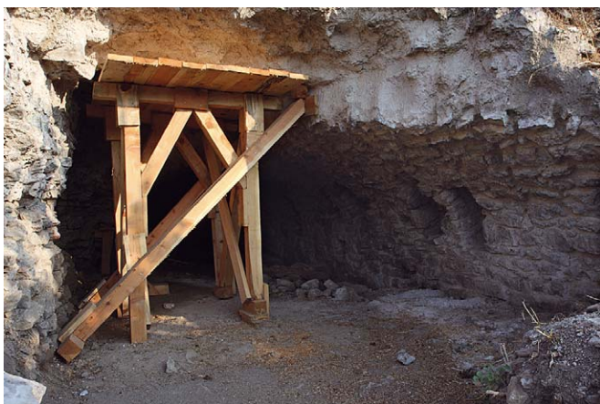
3-4 Kammer 1: provisorische Sicherung (Juni 2011)
