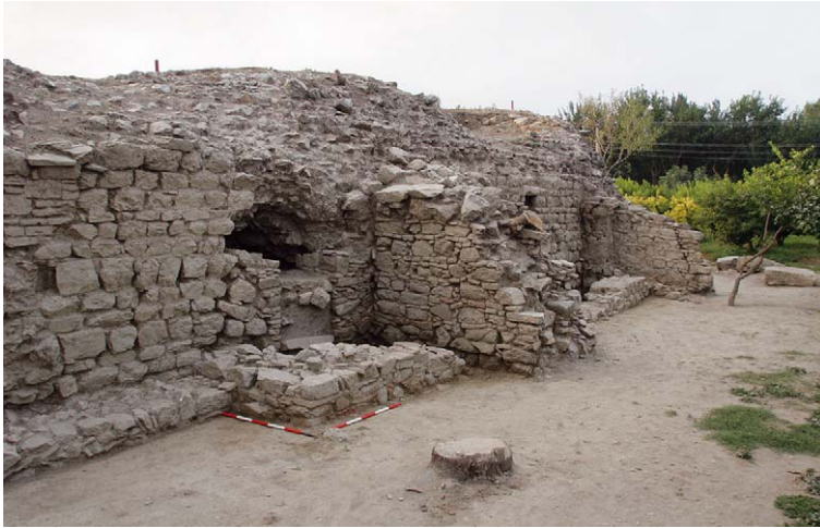
1 Westfassade im Bereich vor Kammer 3
