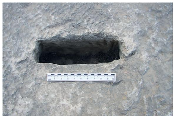
5 Nordfassade, Bogenblock: Zugang Kammer 9, Wolfsloch, Detail
