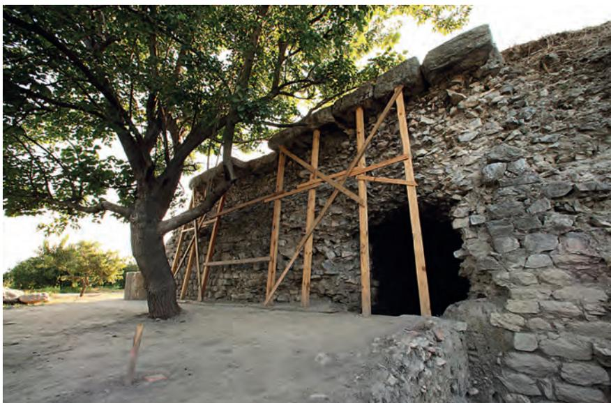
3 Provisorische Sicherung des Gurtgesimses an der Westfassade
