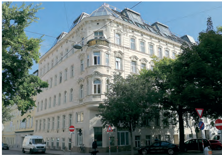
Abbildung 7.4/4: Baulicher Zustand eines parifizierten Zinshauses, periphere Lage (16. Bezirk)
