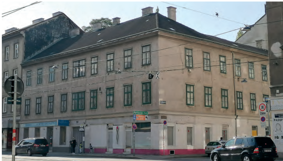
Abbildung 7.4/3: Baulicher Zustand eines nicht-parifizierten Zinshauses, periphere Lage (10. Bezirk)
