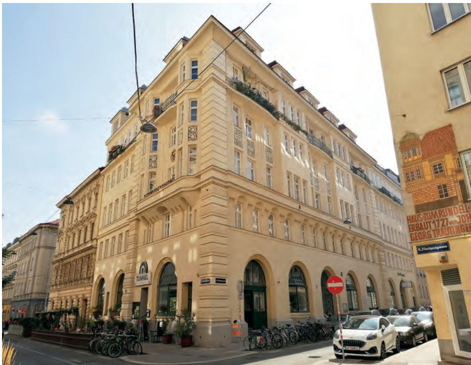
Abbildung 7.4/2: Baulicher Zustand eines nicht-parifizierten Zinshauses, zentrale Lage (8. Bezirk)
