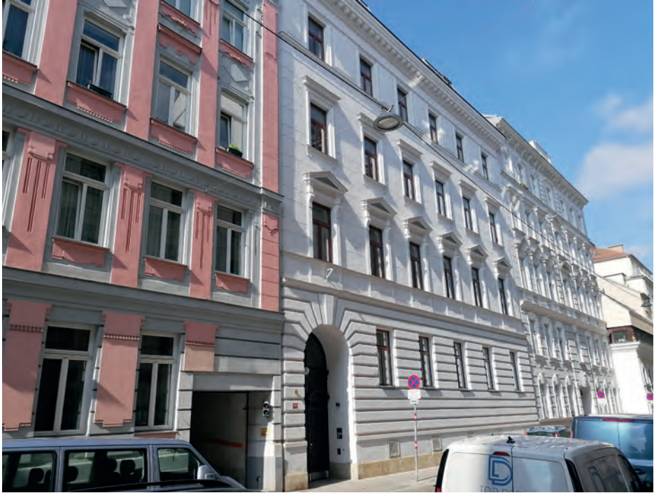
Abbildung 7.4/5: Baulicher Zustand eines parifizierten Zinshauses, zentrale Lage (8. Bezirk)
