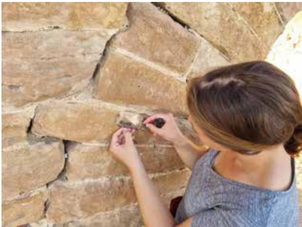
6 Aquädukt im Miliane-Tal südlich von Karthago, restauratorische Befundung | Aqueduct in the Miliane Valley south of Carthage, restorative assessment (© ÖAW-ÖAI, I. Mayer)
