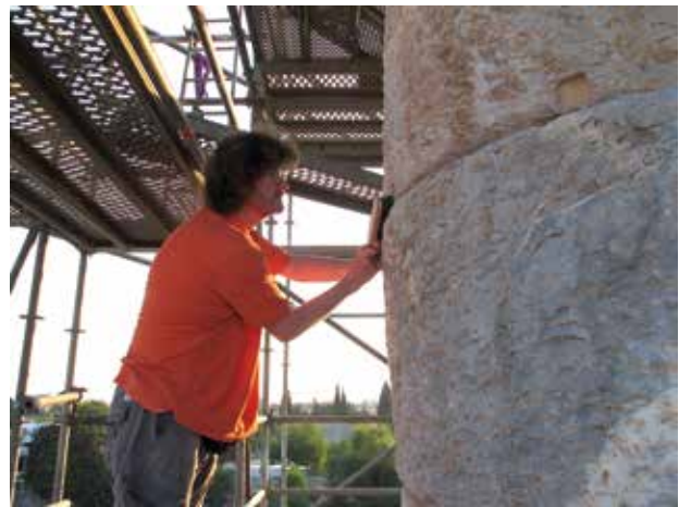
7 Sebastian Prignitz bei der Arbeit an einer Säule in Didyma | Sebastian Prignitz working on a column at Didyma (© S. Prignitz)
