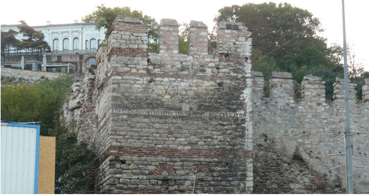
Fig. 3 First tower north of Değirmen Kapısı (© Efthymios Rizos)
