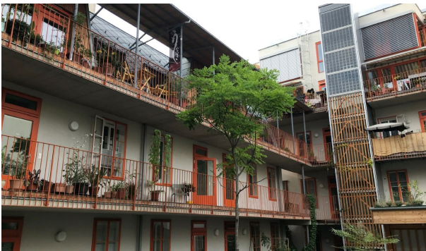
Multi-Energy-System, Geblergasse, 1170 Wien
